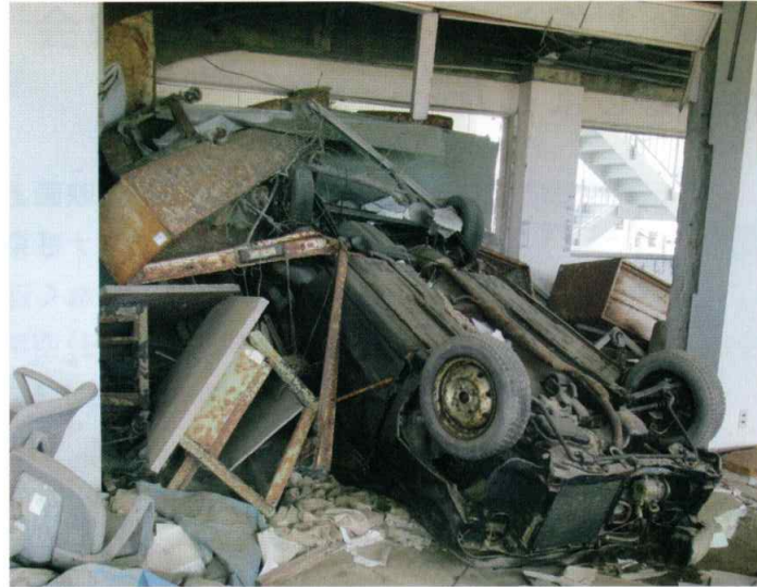
津波で校舎3階(高さ約8m)まで押し上げられた車(人権協撮影) 気仙沼市 東日本大震災遺構・伝承館(旧気仙沼向洋高校)
